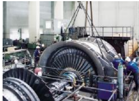
Сл.2.3.19. Поставување на центриран ротор во кукиштето на турбината.
