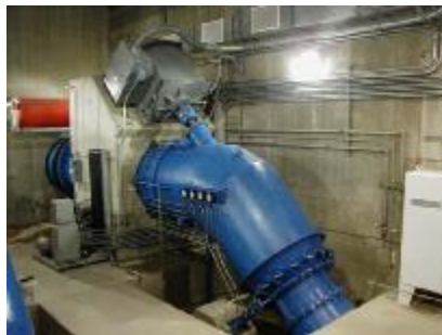
Сл. 3.20 . Регулација на протокот кај Пелтоновите турбини.
