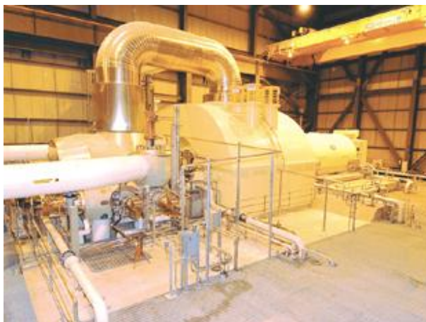
Сл. 2.6.9. Пароводи на влезот во парнотурбински постројки.
