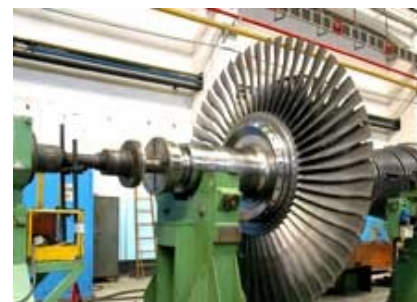
Ремонт на роторот на турбината
