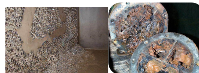
Сл. 10.13. Нечистотии на кондензаторските цевки
