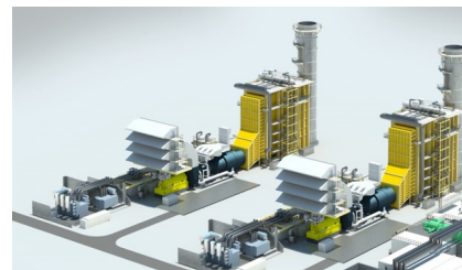
ККТЕП со котли утилизатори
