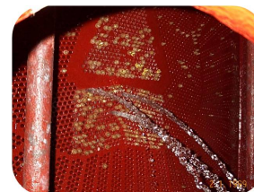
Сл. 10.13. Нечистотии на кондензаторските цевки
