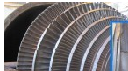
Ремонт на роторот и лопатките на турбината
