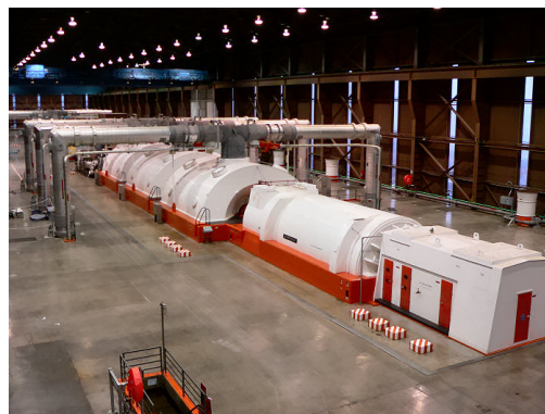
Сл. 5.9. Повеќецилиндрични парни турбини
