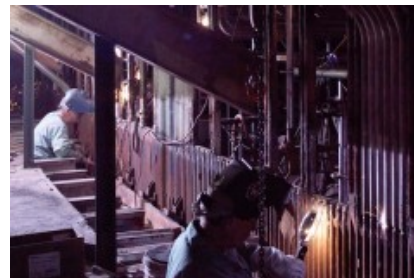
Ремонт на котелска постројка
