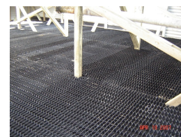
Сл. 5.6.17. Росилник кај ладилни кули од пластични материјали (polyvinyl chloride)
