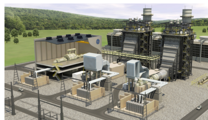
ККТЕП со котли утилизатори
