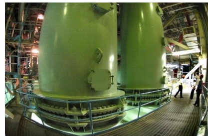
Сл. 5.6.1. Доводни цевки за вода во кондензаторот кај ТЕП
