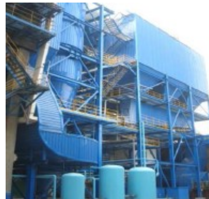
Сл. 9.31. Систем за десулфуризација на гасовите со циркулирачки флуидизиран слој (CFB-FGD)
