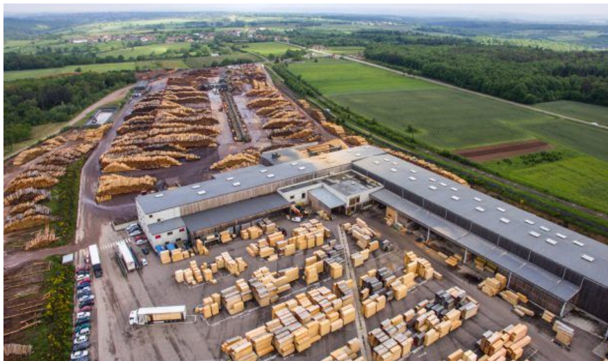
Слика 140. Комуникација во пиланска постројка
